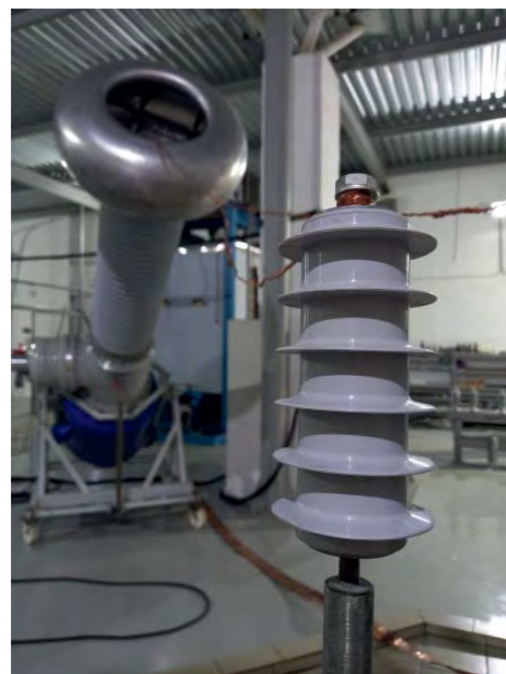
Проверка электрической прочности изоляции ОПН
